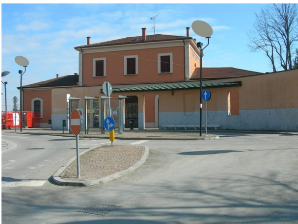
Stazione di Crevalcore, dal piazzale e dalla banchina
